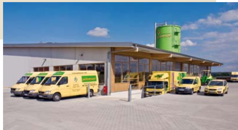
Die neu errichtete Produktionshalle mit dem modernen Fuhrpark der Schreinerei. Der Neubau des Bürogebäudes folgt in Kürze.
